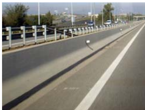
Figura 5-7: Barrera de hormigón
