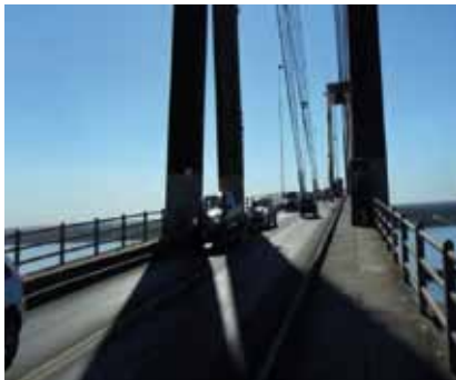
Precaución al Circular en Puentes
